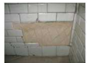
Detalle de paramento de pequeño formato rematado para realizar el alicatado
