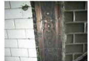
Ejemplo de azulejos antes y después de la limpieza
