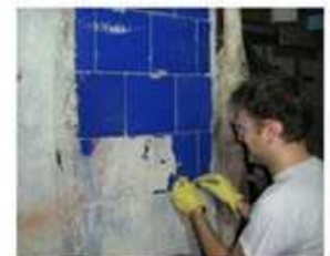
Eliminación de depósitos de suciedad adheridos, pinturas plásticas aplicadas
