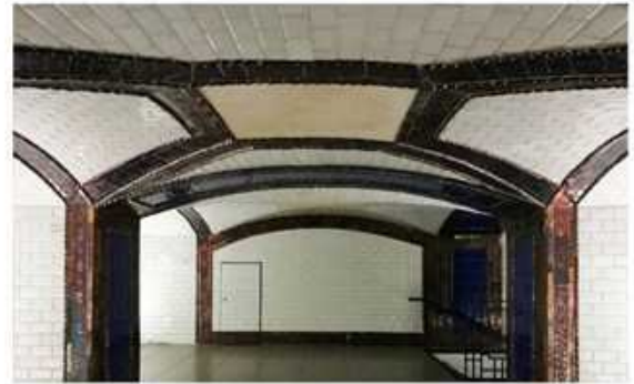
Vista del vestíbulo en su estado actual, mayo 2017 [Rafael Valero, Archivo Histórico de Metro de Madrid]
